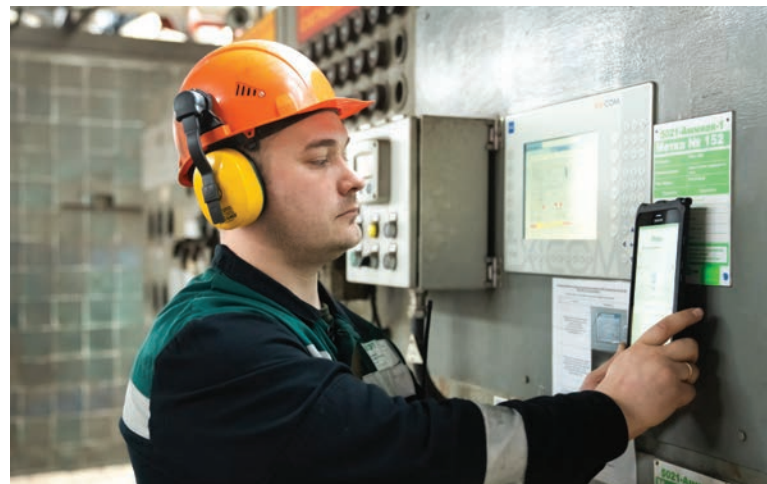
▲ Эффективность обходов зависит от достоверности, полноты и оперативности собираемых данных о фактическом состоянии оборудования
